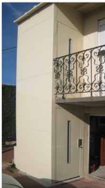
Gaine tôle sur pylone auto-porteur
